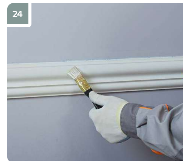
24 Следуя инструкции производителя краски, произвести окраску изделий, начиная от угла помещения.
