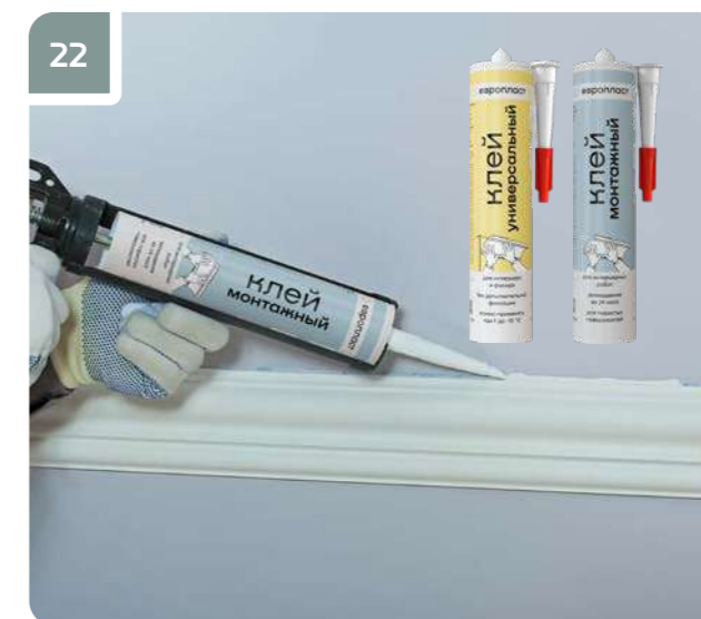
22 Заполнить клеем места примыкания изделия к стене на тех участках, где клей не выступил.
