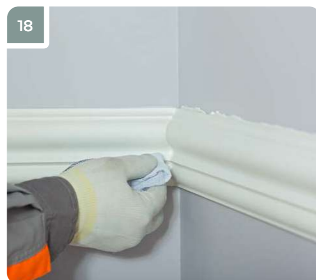
18 Протереть стык ветошью, смоченной ацетоном.
