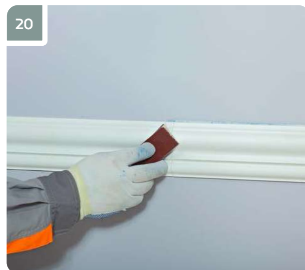
20 Обработать стыки мелкозернистой наждачной бумагой спустя 4 часа, если при монтаже изделий к стене использовался клей «Европласт Универсальный». Обработать стыки спустя 12 часов, если при монтаже изделий использовался клей «Европласт Монтажный».
